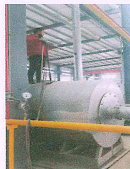
3#底漆固化炉排气筒 出口检测口
