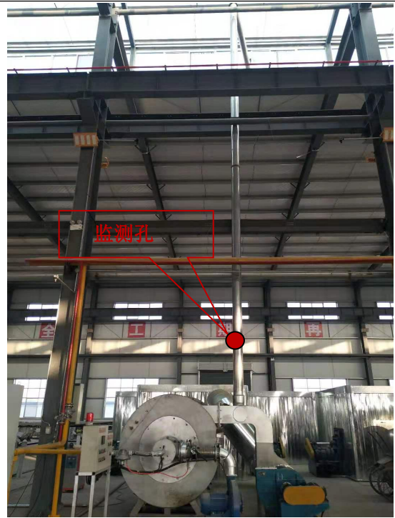
面漆固化炉 15m 排气筒
