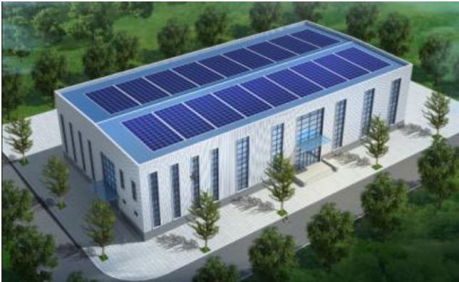
图 4.9.5-2 保障点光伏发电组件布置示意图
