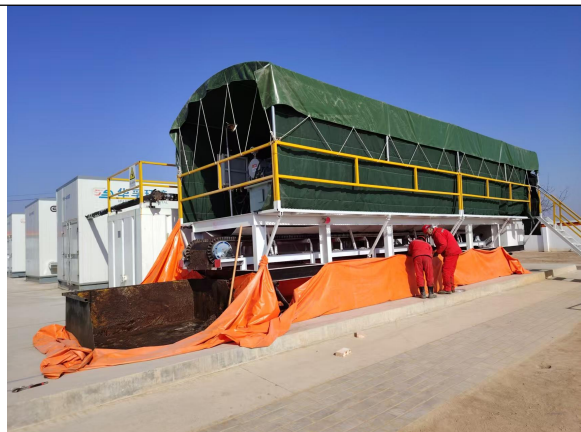
污泥压滤装置
